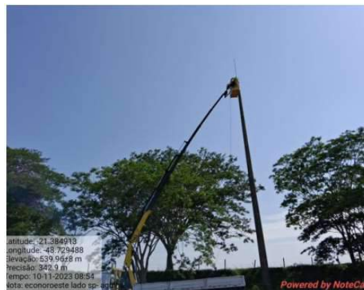
Imagem 75: Substituição das lâmpadas (PD: 3).
